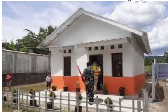
Gambar 4 relokasi rumah tahan gempa
